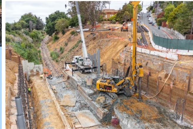
CIDH Wet Piles
